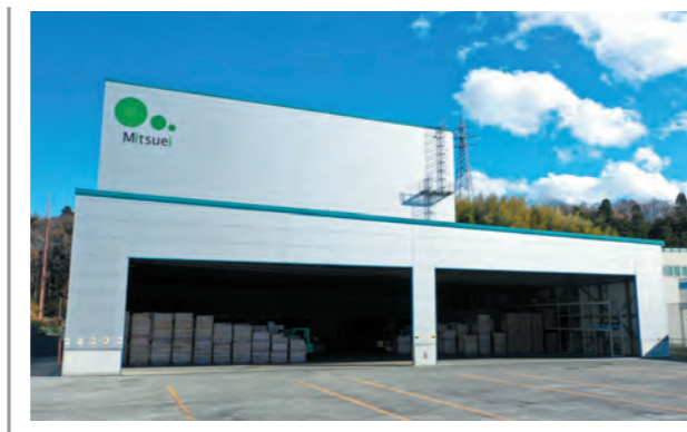
●いわき本社第2工場 自動倉庫
